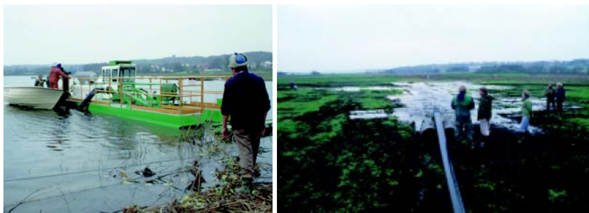
Figur 40. Specialfartøjet Mudcat, der oppumpede sediment i Brabrand Sø, samt afvandingsbassin til sedimentet. Foto: Aarhus Kommune.
