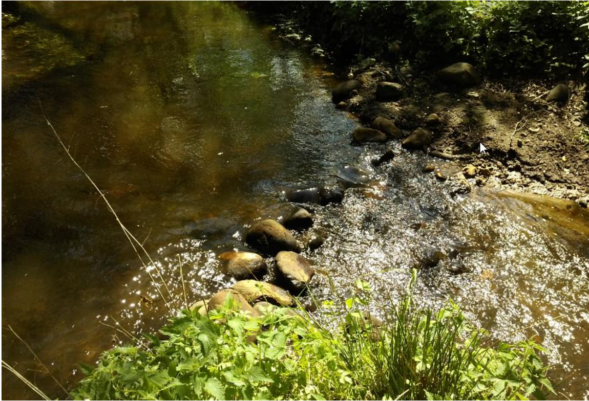
Fordelerbygværk ved indløb til mølledam. Vandindtag reguleres ved at flytte sten i indløbet
