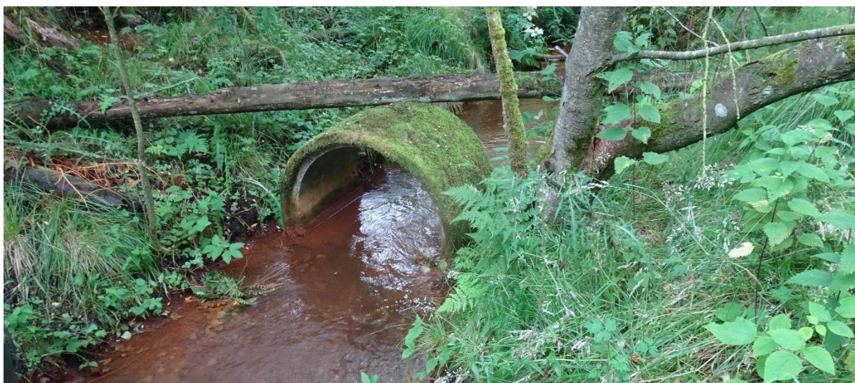
Figur 4.2.3 Tidligere betonrøroverkørsel ved st. 7.988, der skal fjernes.
