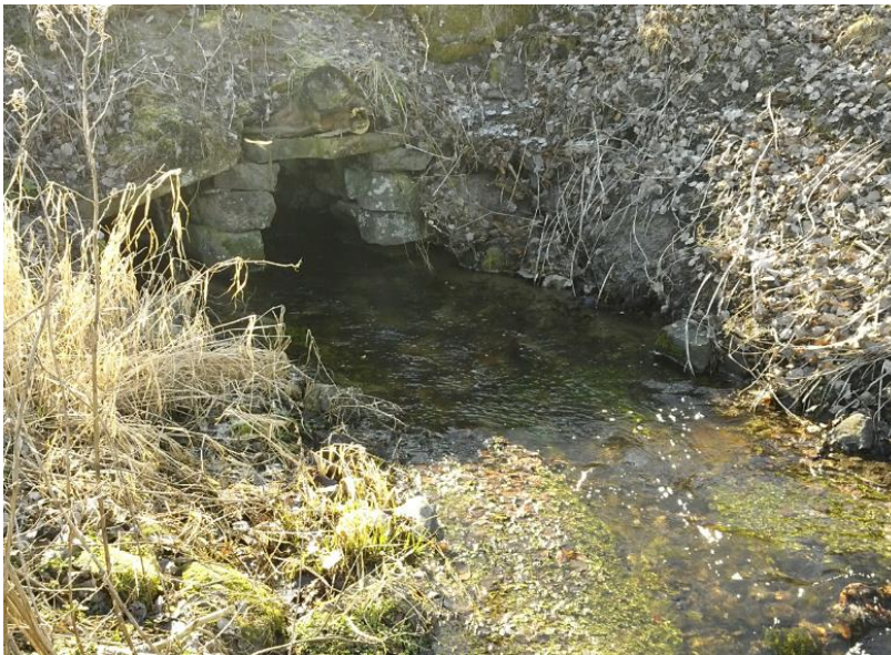
Vandløbet ca. st. 2.360 nedstrøms underføring under Bækgårdsvej
