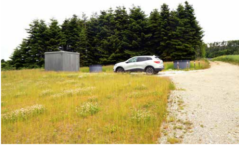
Tindbæk Renseanlæg er erstattet af en pumpestation.
