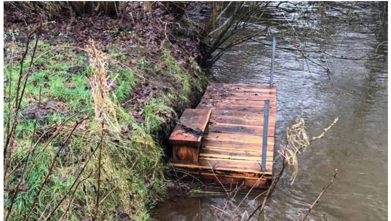
Isætningsanlægget ved Rindholm.
