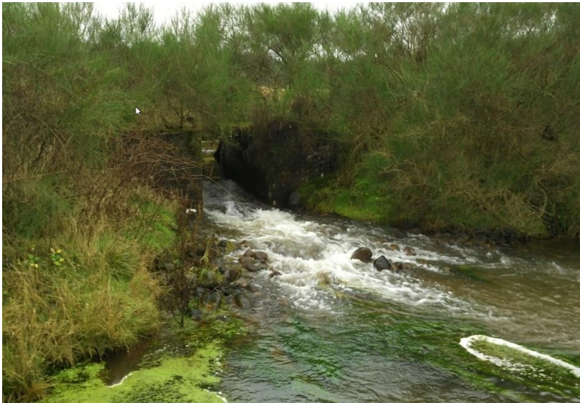
o8730_c Haller Å – stemmeværk ved det nedlagte Vallerbæk Dambrug
