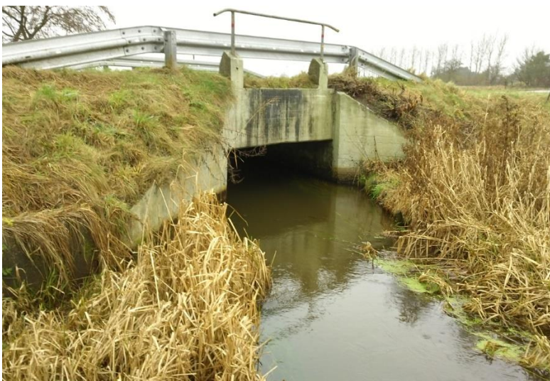
Vejunderføringen ved Vallerbækvej
